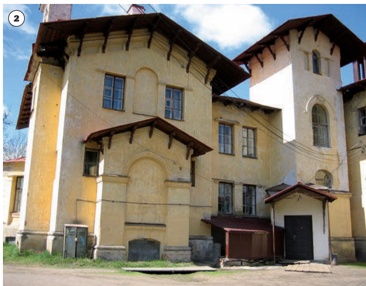
1. Отдых В. Мономаха после охоты. В. Васнецов, 1893 г. 2. Императорский Охотничий дворец в пос. Лисино-Корпус, построенный в 1860 г. по проекту Н. Бенуа. Фото В. Масайтиса
